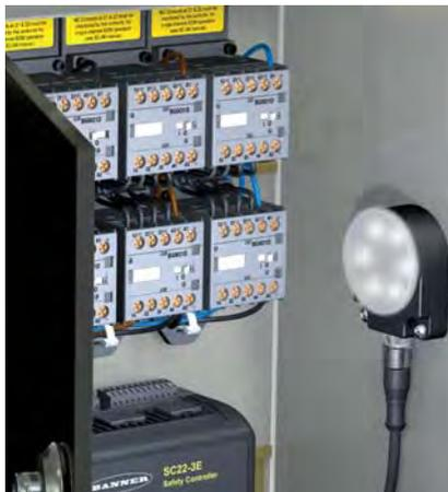
Das Ein-/Ausschalten der Leuchten erfolgt entweder über die Zuschaltung der nötigen Versorgungsspannung (10...30 VDC) oder – bei konstanter Spannungsversorgung – über den bei einigen Varianten integrierten Schalter direkt an der LED-Leuchte.
