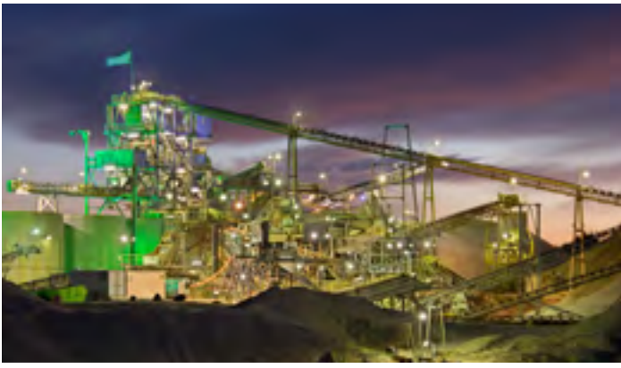
Flexibilität in der Ausrichtung der Fluter lässt Kraftwerke und große Förderanlagen optimal und wirtschaftlich beleuchten
